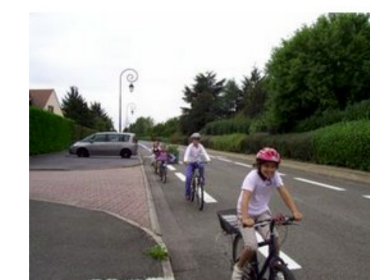
Chaucidou à Buc (avec marquage "bandes cyclables" T3 5u (largeur 25 cm))
